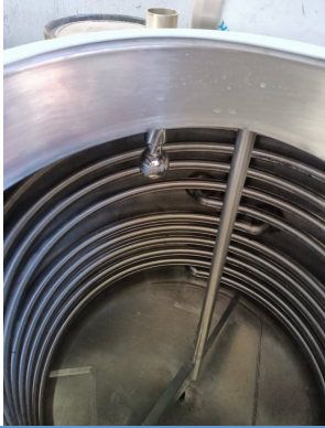
SOĞUTMA TANKI (-15°C) (COOLING TANK -15°C)
